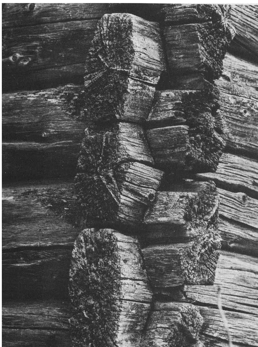
LAFTEHODER: Det er sammenføyningen av tømmerstokkene i hus-hjørnene som er det helt spesielle med lafteteknikken. Endene av tømmerstokkene som stikker utenfor, kalles laftehoder. Måten de er utformet på kan være et kjennetegn for dateringen av gamle tømmerhus. Her ser vi sekskant-formede laftehoder på husmannsstua Ekerhaugen i Biri. Sekskantflatene var vanlige på 1700-tallet.
