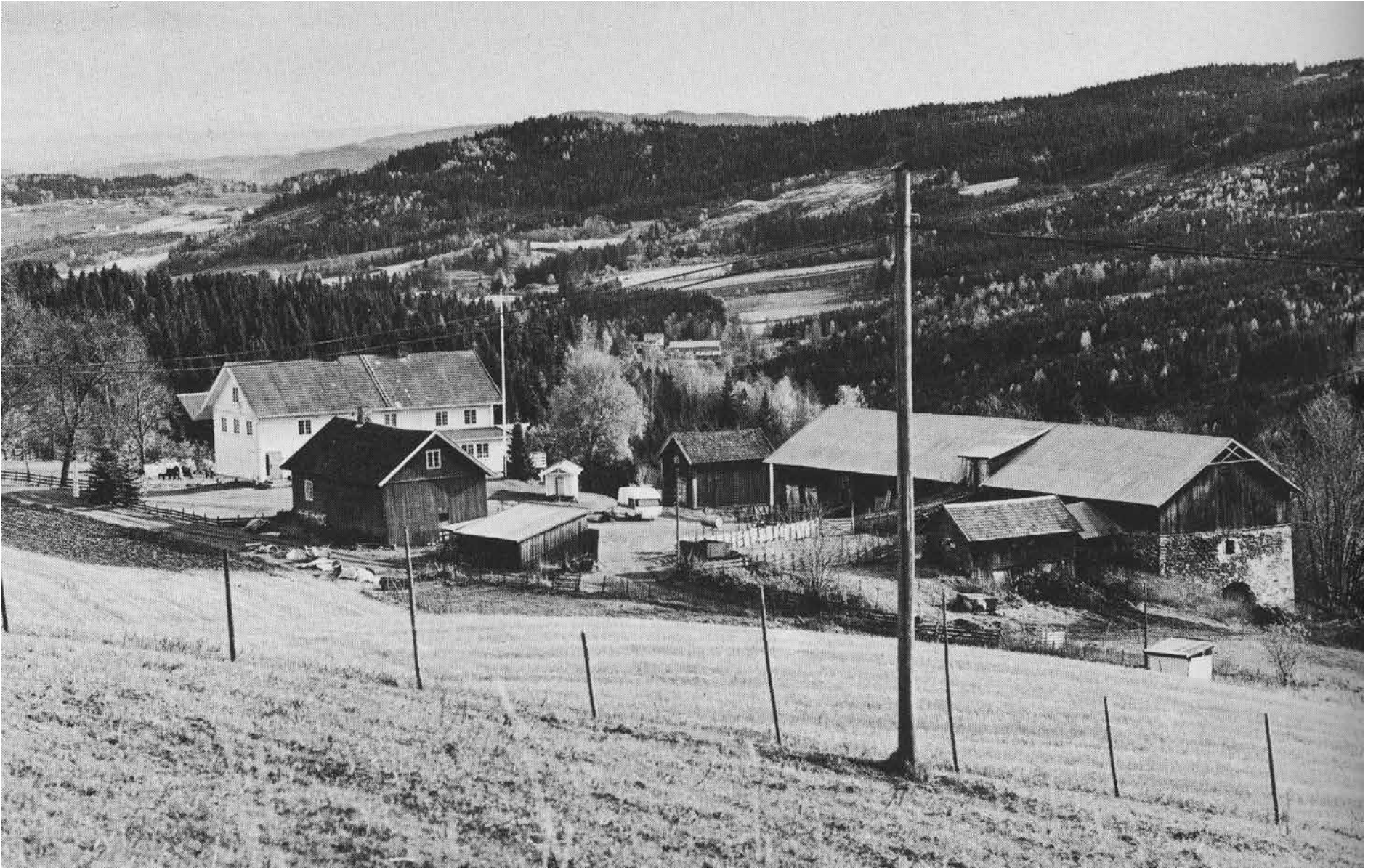
GARDSTUN: Åpent firkanttun på Nordre Hegge.
