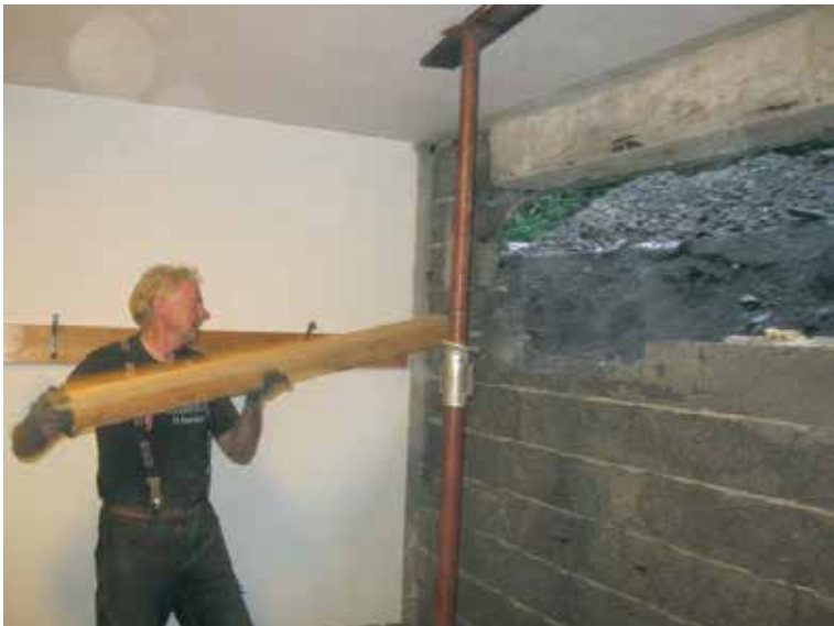
Bjørn Feiring har startet riving av muren.
