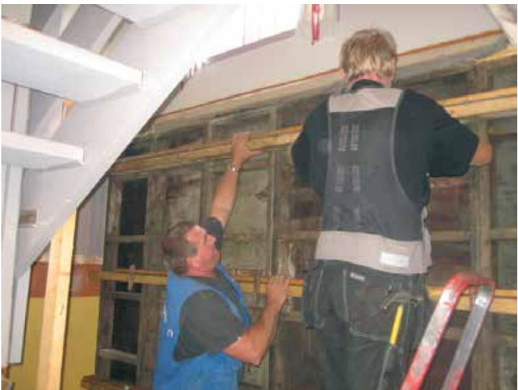
Roger Sletten og Bjørn Feiring er snart ferdig med den innvendige forskalingen.
