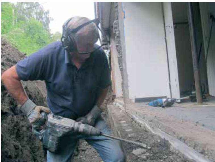
Bjørn Haugelien pigger ut den siste delen av grunnmuren.
