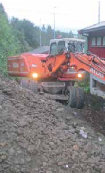
Tåle Kjenseth i gang med å grave ut på baksiden
