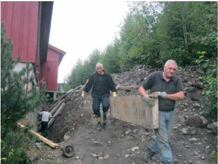
Bjørn Haugelien og Kjell Hagen i gang med å rive forskaling.
