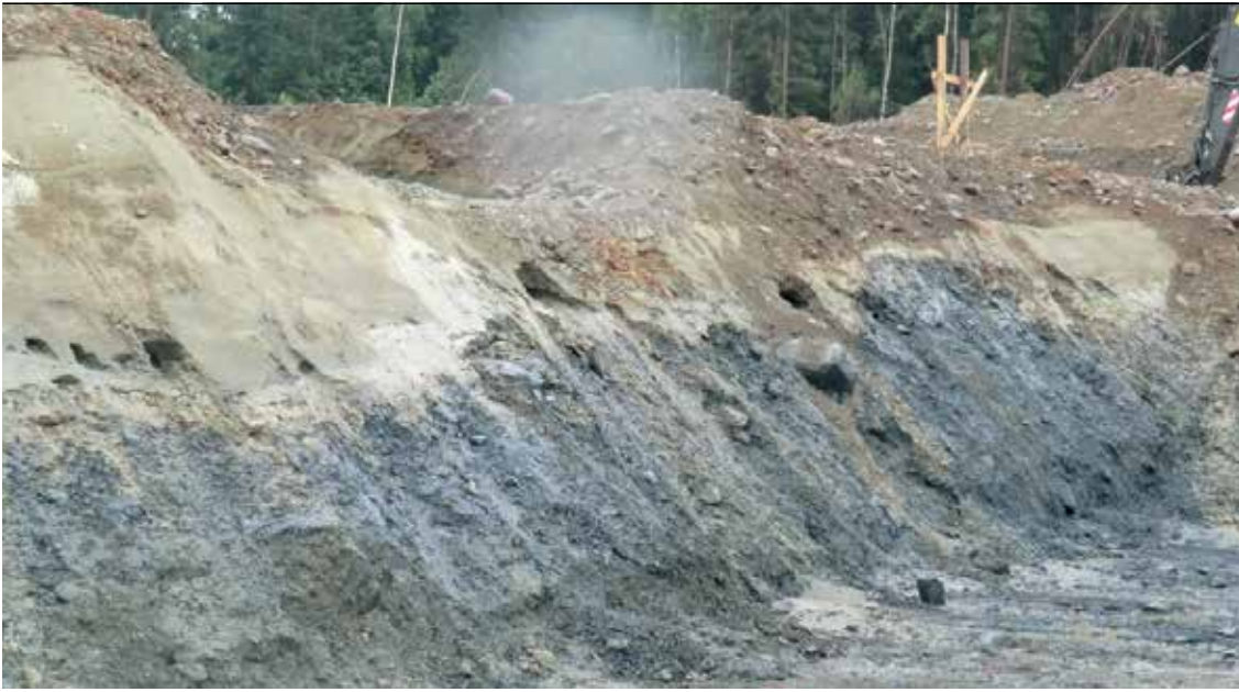
Snitt fra gravearbeidene på det nye trykkeriet. Underst ser vi gråfarget bunnmorene, så ligger lagdelt sand og så ligger grovmaterialet fra Vismunda på toppen.
