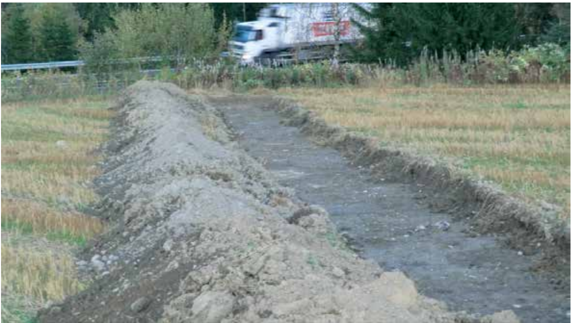
MASKINELL FLATEAVDEKKING: I oktober langs E6 på Myhre på Birstrand. Langs Stranda ble det ikke funnet så mye spennende, men ved Svennes derimot blir det mer å grave i senere. Dette er en metode for raskt å skaffe seg oversikt når det skal foretas større byggearbeid med vegger.
