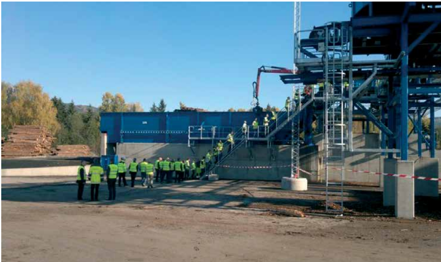
STORE FORHOLD: Gjester på omvisning i anlegget.
