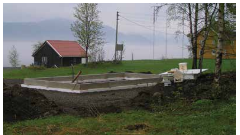
Fra bygging av bade/dusj-toalett på Strandenga.
