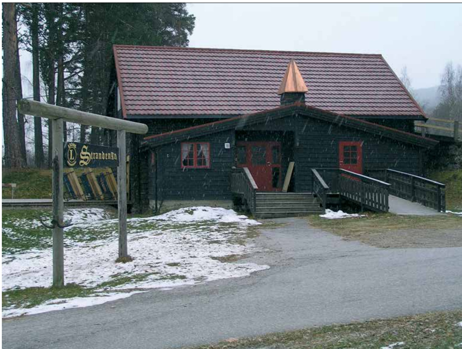
«Låven» i lett snøvær, med nytt tak – fagmessig utført av P.K. Tranberg sine utmerkede håndverkere.
